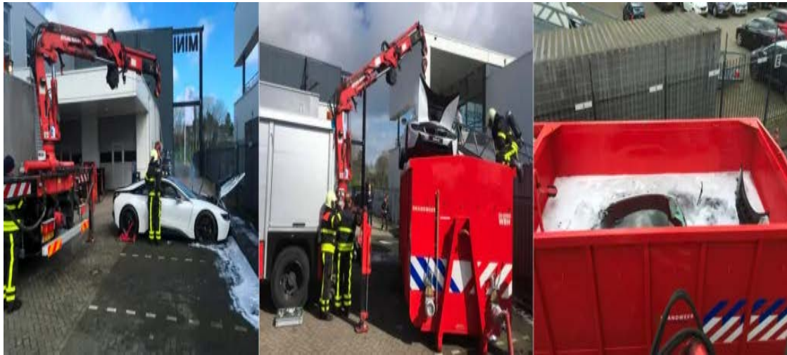
Şekil 27. Elektrikli Araç yangınlarına müdahale yöntemlerinden su dolu konteyner uygulaması
